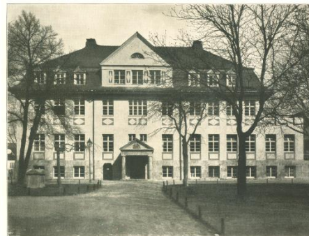
ABB. 77. FEODORAHEIM AM ALTEN JAKOBSFRIEDHOF. PLATZANSICHT
